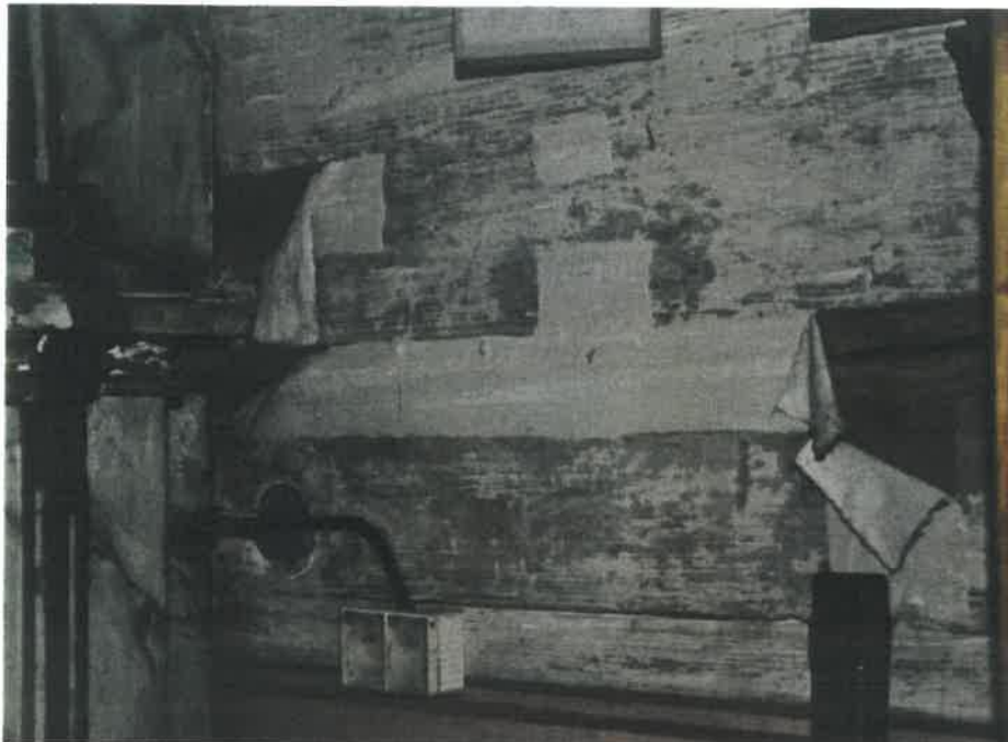
Zniszczenia warstwy malarskiej ścian kościoła w widocznych próbach napraw za pomocą naklejania plóciennych pasów i instalacją elektryczną
