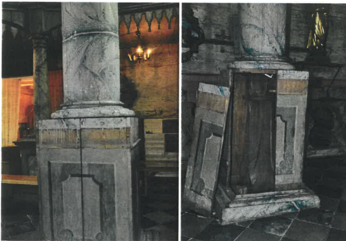
Zniszczenia warstwy malarskiej ścian kościoła w widocznych próbach napraw za pomocą naklejania plóciennych pasów i instalacją elektryczną
